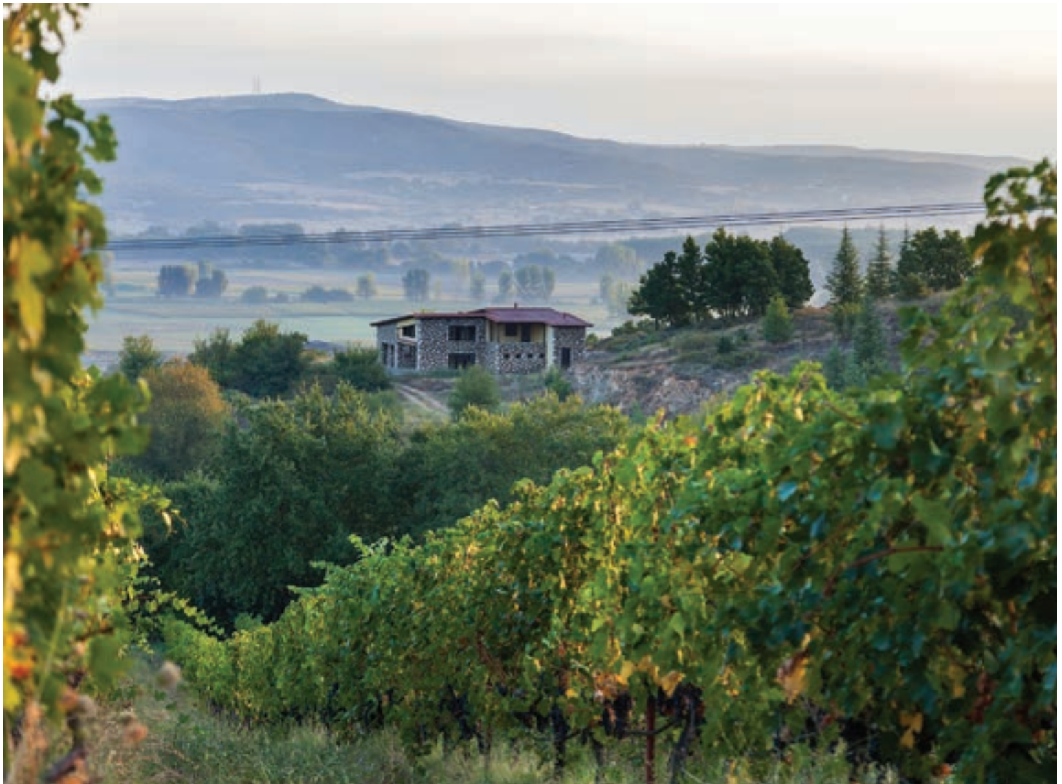
Μέσα στον ιδιόκτητο αμπελώνα του κτήματος χτίστηκε το νέο υπερσύγχρονο οινοποιείο, το οποίο αναπτύσσεται σε δύο επίπεδα, το ένα υπόσκαφο στο βουνό.
